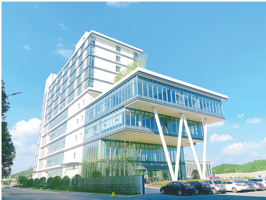
中天抗蒋科研楼是全省首个采用钢管混凝土土组组合结构项目
