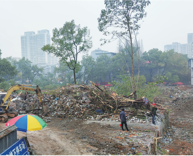
11月16日,项目地块顺利清场。株洲日报·掌上株洲记者/杨凌凌 摄
