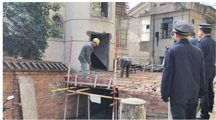
▲拆违现场。通讯员/供图
