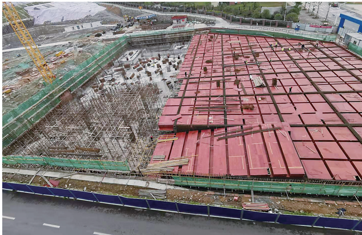
◀华锐精密二期项目施工现场。株洲晚报融媒体中心记者/廖喜张 摄
