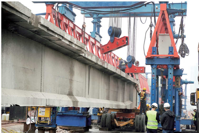
▲10月29日,新华桥二跨三号T梁梁体顺利拆除。株洲晚报融媒体中心记者/刘震 摄
