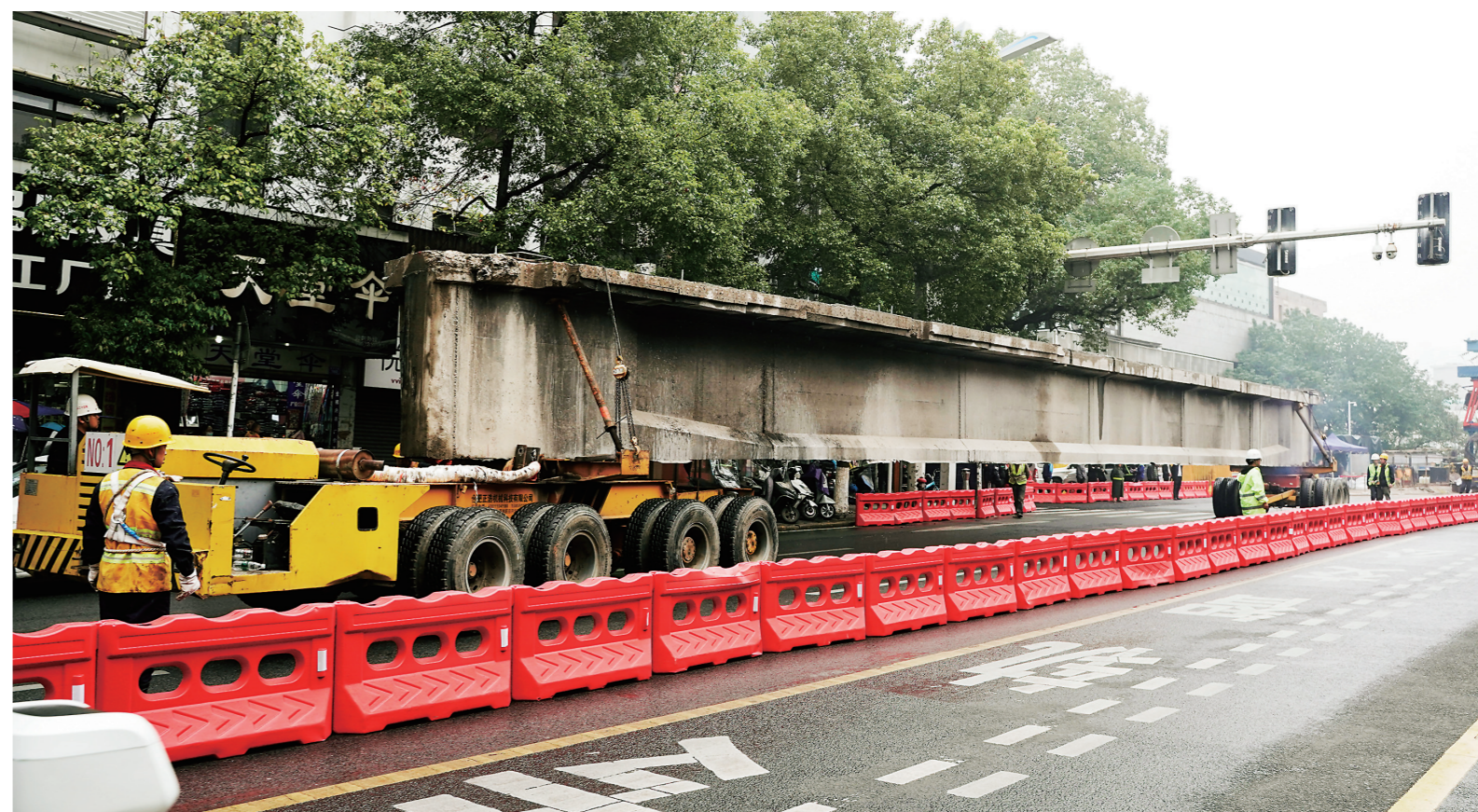
▲10月29日,新华桥二跨三号T梁梁体顺利拆除。株洲晚报融媒体中心/刘震 摄
