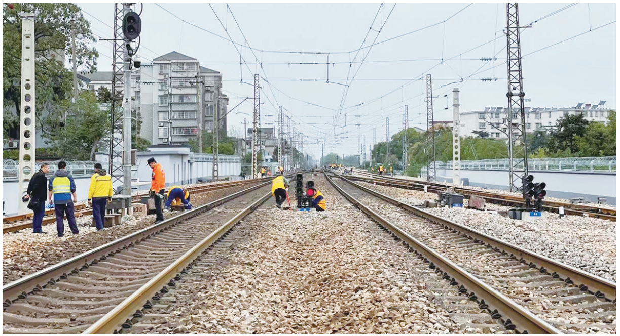
▲图为大修施工现场。记者/廖明 摄
