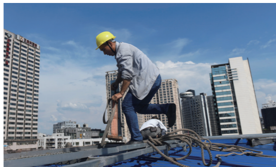
▲固定好安全绳的李建军，准备下到高楼的外围作业。
