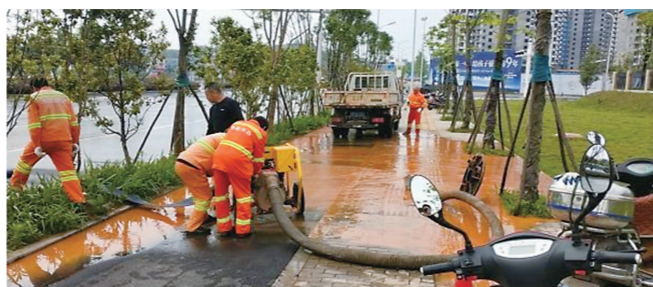
▲天元市政工作人员正在进行清淤工作。通讯员供图
