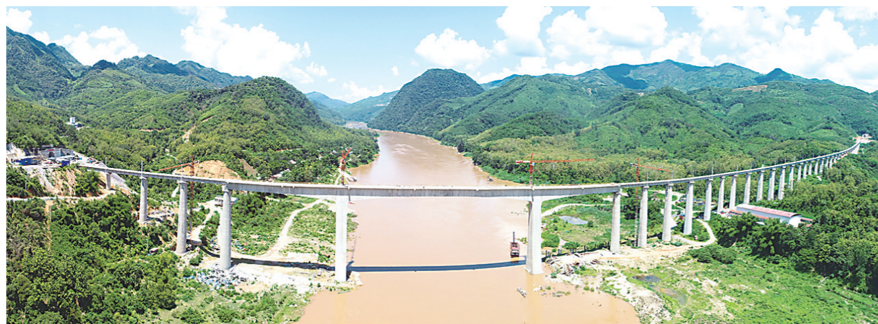
▲去年7月24日,在老挝拍摄的中老铁路班纳汉湄公河特大桥(无人机照片)。新华社发
