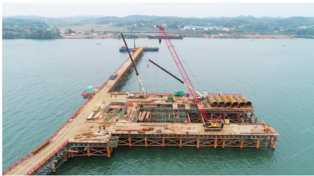
▲航拍醴娄高速湘江特大桥项目施工现场。株洲晚报融媒体记者/谭浩瀚 摄
