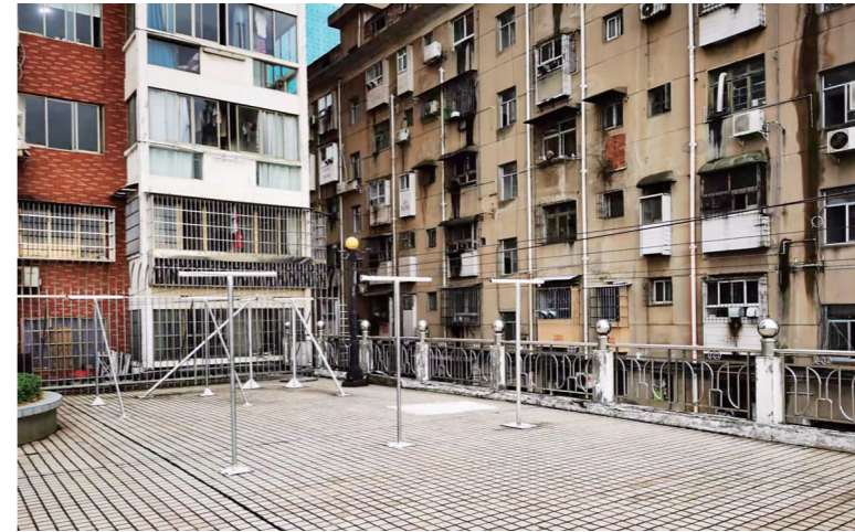
▲经过改造后的居民活动场地。记者/杨凌凌 摄
