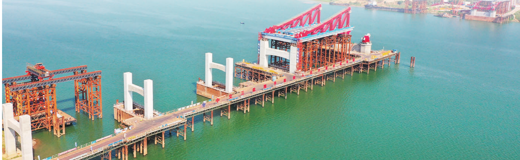
▲清水塘大桥项目,目前正在进行大桥下部结构承台、墩柱以及大桥上部结构现浇箱梁施工。中秋假期,现场的施工人员正常上班。株洲晚报融媒体记者/谢慧 摄
