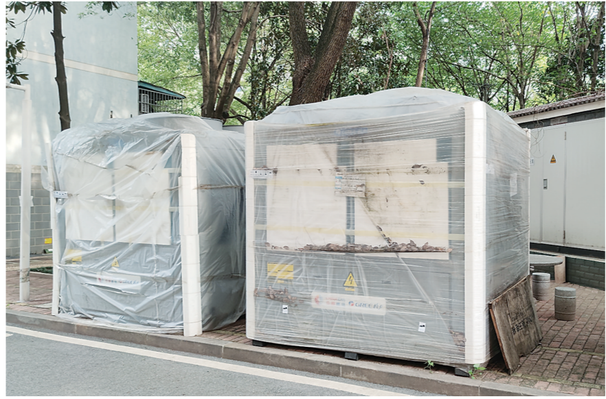
▲市水利局家属小区正在安装集中供暖设施。受访者供图
