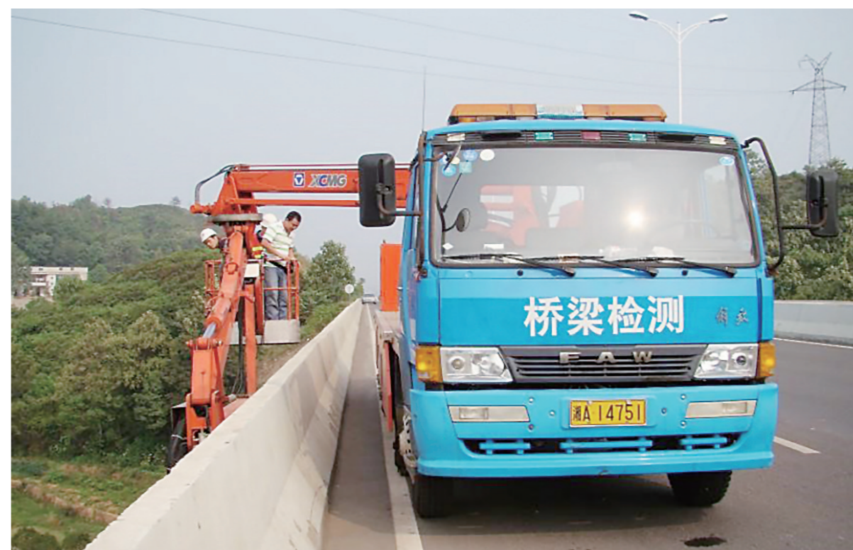
▲城区桥梁“健康状况”检测现场。通讯员供图
