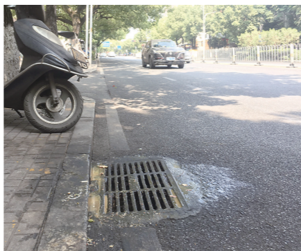
▲漏水往排水口倾倒。记者/刘平 摄
