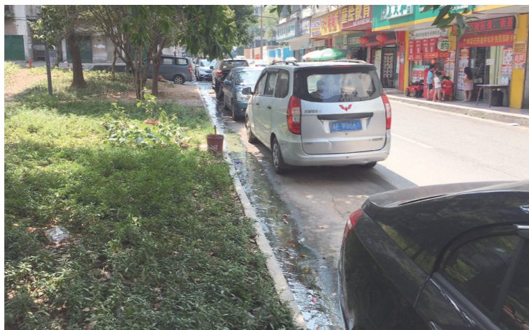
▲污水沿着马路边流淌。记者/刘平 摄
