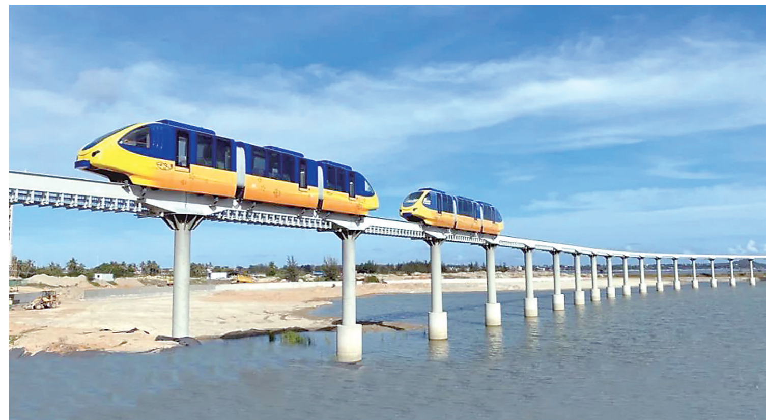
▲近日,由株洲中车特种装备科技有限公司完全自主研发的全国首列浅海运营单轨观光列车,即将调试完毕进入试运行。这是该公司为海南陵水海洋欢乐世界量身打造的一款全新列车,集观赏和交通两大功能于一体。更重要的是,这是一款可以在海上“低飞”的小火车。按照项目的设计理念,车辆运行时距离海面6至7米,其中有超过1公里在内海运行。(株洲晚报融媒体记者/高晓燕 通讯员/欧阳柳 摄影报道)
