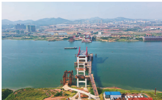
▲清水塘大桥,正在进行大桥下部结构承台、墩柱、大桥上部结构现浇箱梁的施工。
