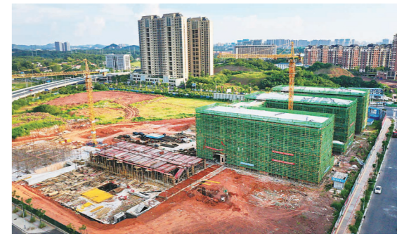
▲长沙市一中云龙实验学校,目前,教学楼完成封顶,教学楼砌体全部完成;地下室底板、顶板完成混凝土浇筑,科技楼一层地面完成施工;预计明年秋季新校区将投入使用。
