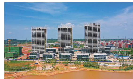
▲天易科技城株洲信息港项目一期主体工程已经完成,正在进行内外装饰装修,部分研发、孵化楼年底投入使用。
