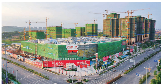
▲去年底,万达广场主体工程完工,正在进行广场内部装饰装修,以及内部管线施工,预计10份完工。广场计划在2021年12月底开业。
