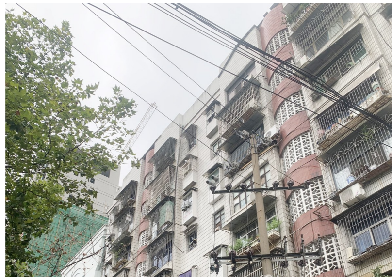
▲临街花窗处安装电梯,需占用临街店面。
