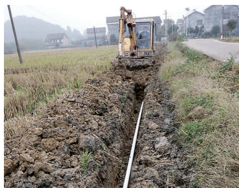
▲醴陵市板杉镇板杉村自来水管网铺设现场。市水利局供图
