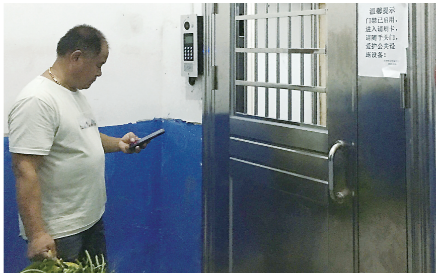
▲地下车库与电梯之间的安全出口设有门禁。 记者/刘平 摄
