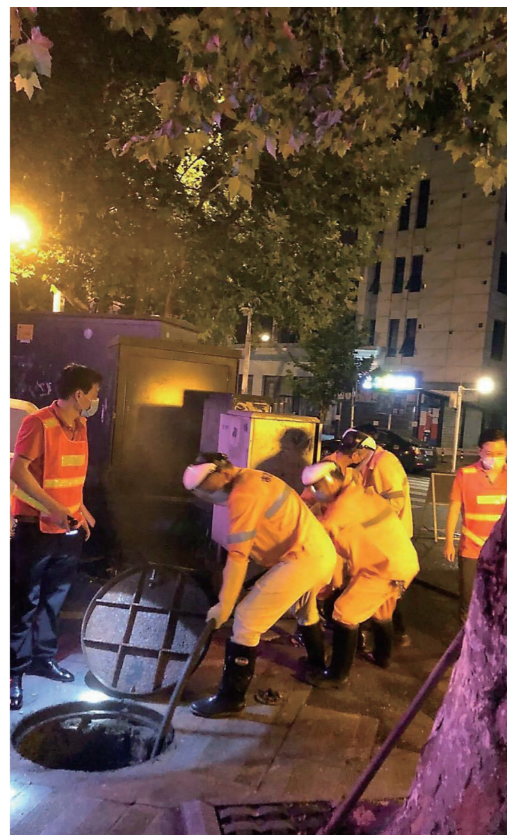
▲市政部门对道路排水管道进行清掏疏浚 通讯员/供图
