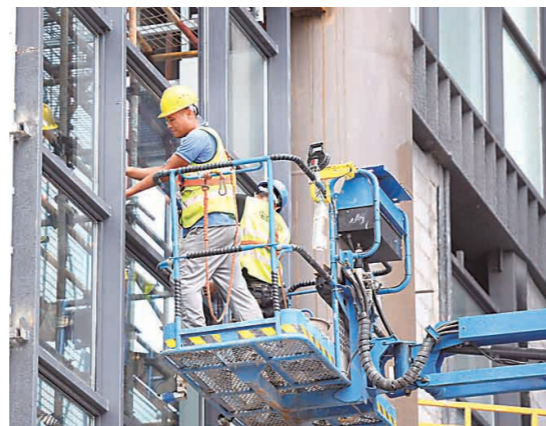
▲株洲站改扩建工程建设现场,工人师傅正在给车站楼安装玻璃。
