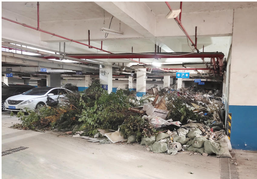
▲地下车库堆积着建筑垃圾和树枝。记者/邱鹏 摄
