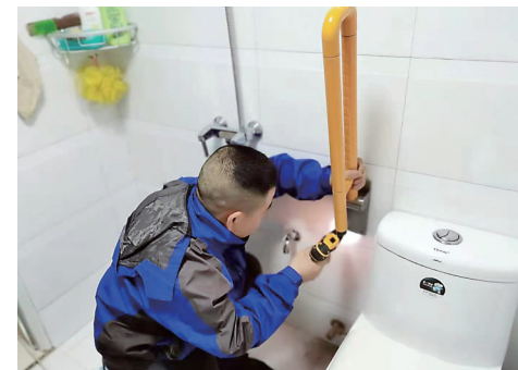
▲工作人员正在对老人家进行适老化改造。通讯员供图
