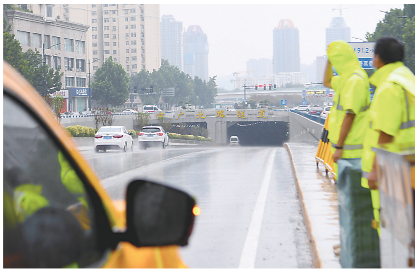
▲8月22日,工作人员在郑州市京广北路隧道入口处值守。
