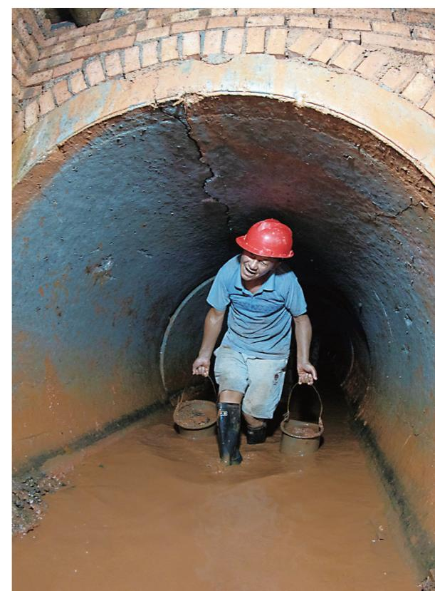
▲暗涵里有一段“硬骨头”,长30米,直径只有1.5米,淤泥只能猫着腰,将淤泥一桶桶地提出来。
