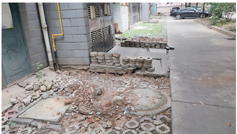
▲滨江一村,未复原的施工坑道随处可见。记者/戴凛 摄
