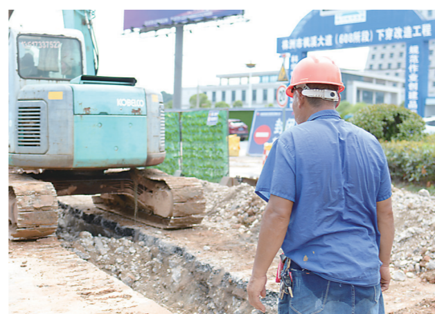
▲枫溪大道边,管道铺设工作正在加紧进行。
