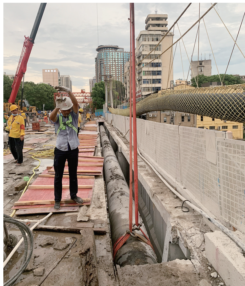
▲新华桥南侧的铸铁水管,正准备拆除吊离。记者/廖明 摄
