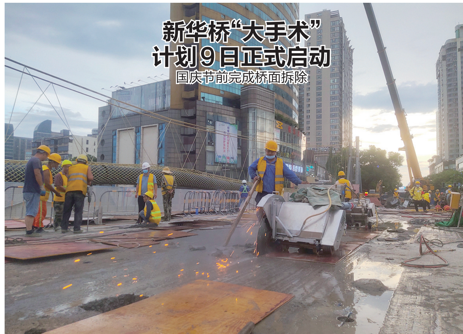
▲施工人员正在对新华桥桥面进行切割。株洲晚报融媒体中心记者/廖明 摄
