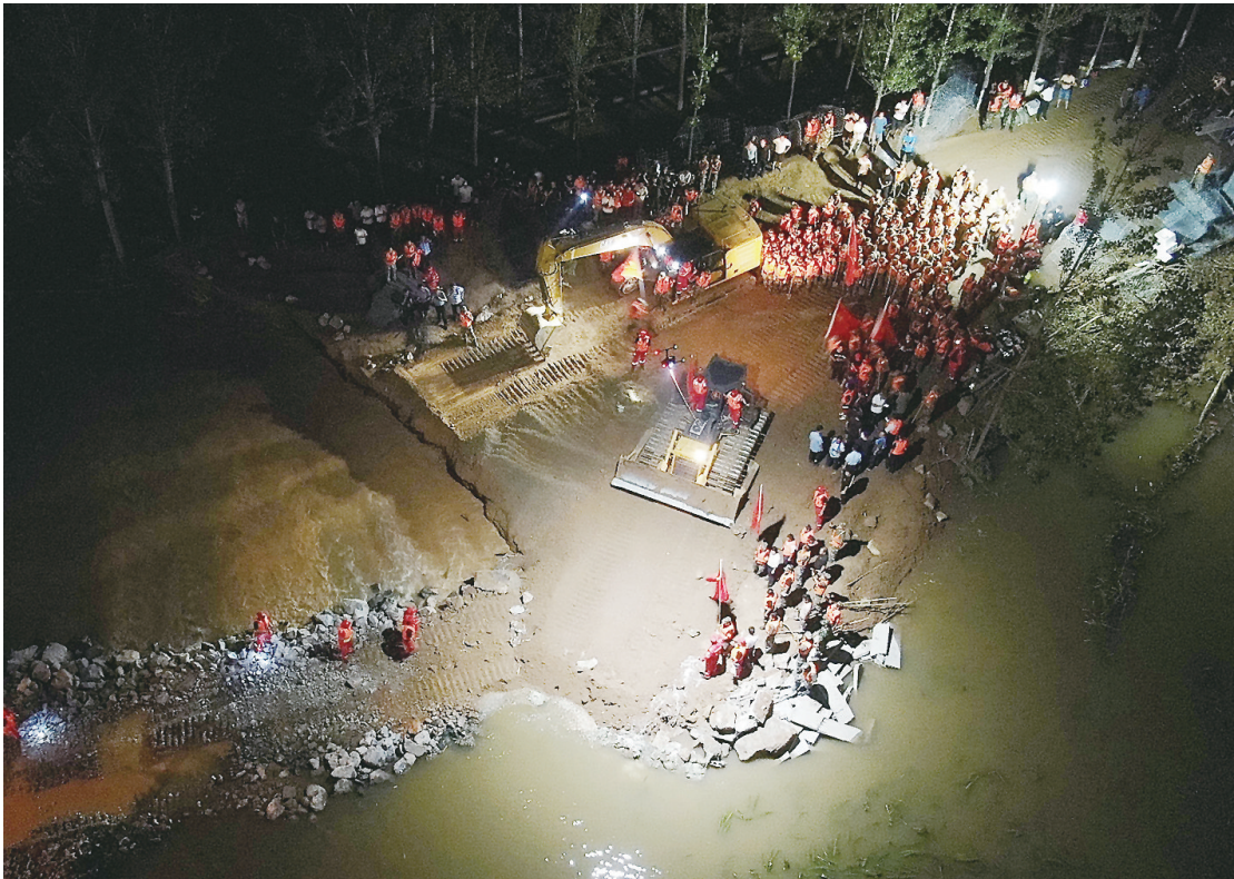
这是7月26日拍摄的卫河鹤壁市浚县新镇镇彭村决口封堵现场(无人机照片)。受持续性强降雨影响,卫河河南省鹤壁市浚县
