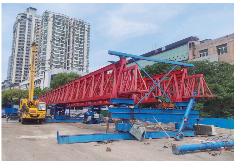
▲新华桥西头,已经完成组装的架桥机。 记者/廖明 摄
