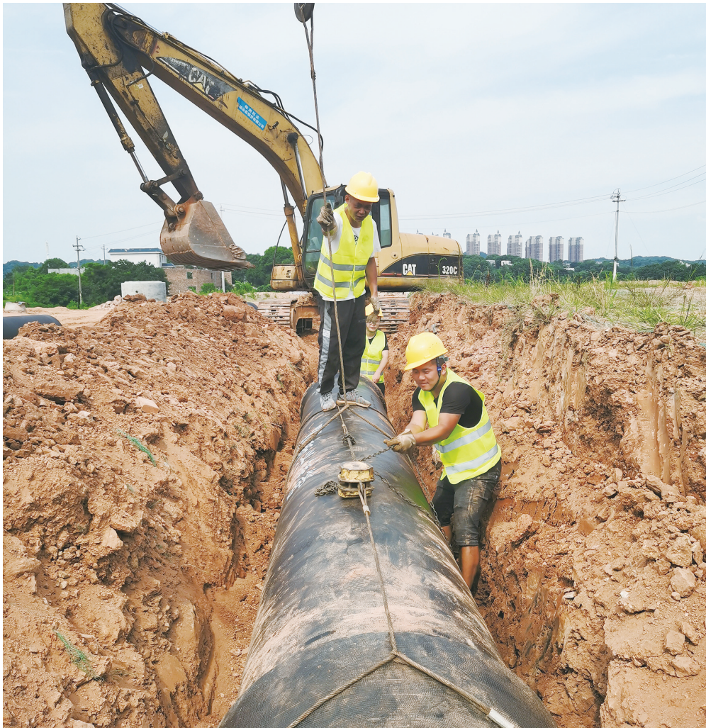
包新敏和同事们正在沟槽里施工。株洲日报·掌上株洲记者/易蓉 摄
