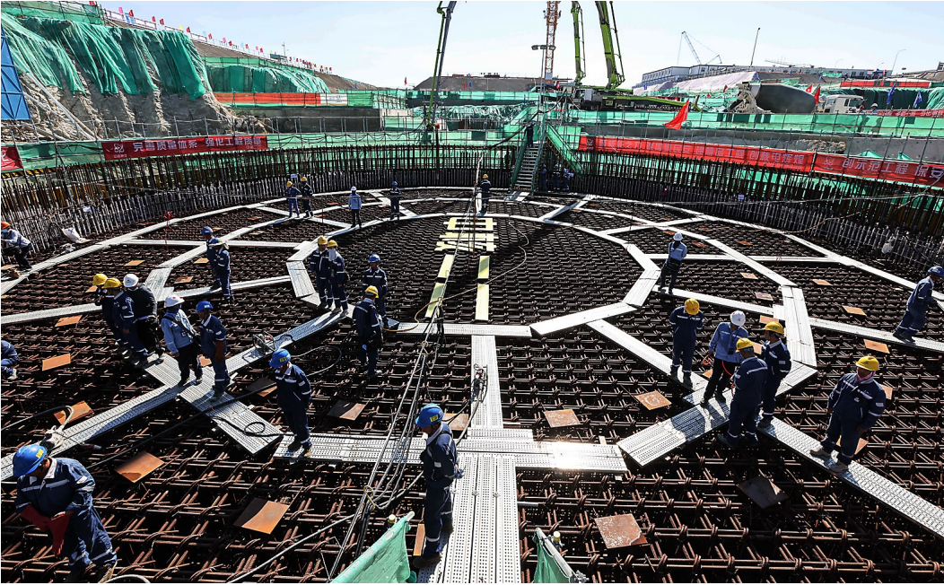
7月13日，工人在海南昌江“玲龙一号”施工现场工作。新华社记者 张丽芸 摄
