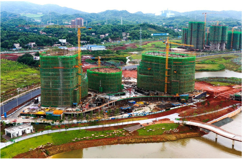
环湖科创园项目现场,投资约7.3亿元,总建筑面积12万平方米。
