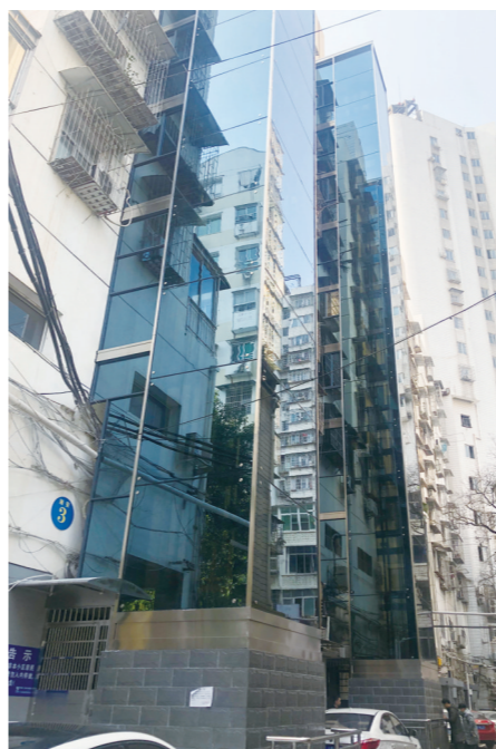
▲湘安小区加装的电梯(资料图)。 株洲晚报融媒体记者/周嵩 摄
