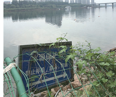
▲江边隔离护栏破损严重。记者/刘平 摄
