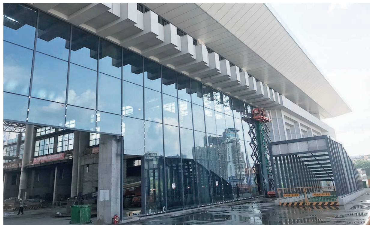
▲株洲火车站东站房主体已完工。记者/胡文洁 摄
