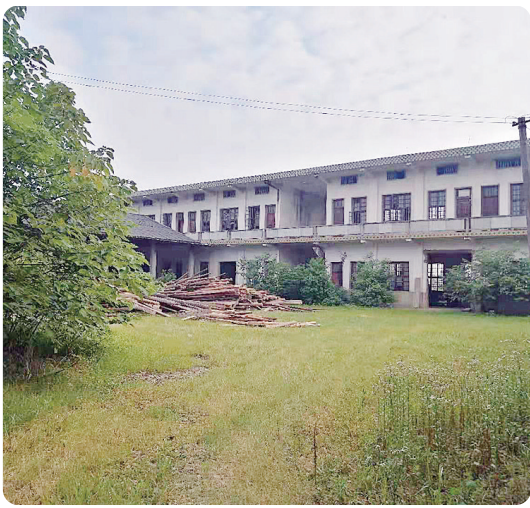
已经荒废的罗家潭学校。
