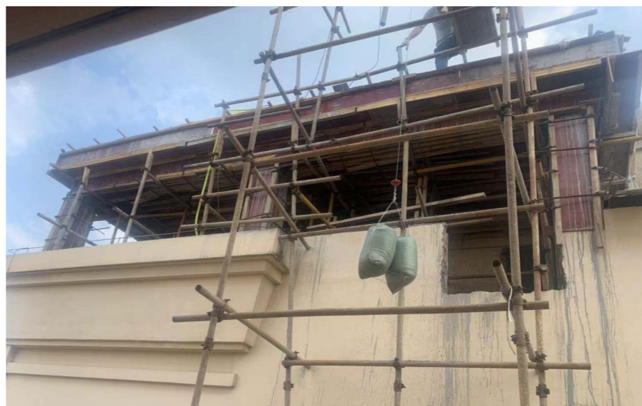
▲工人使用起重机往违建处运送建材。记者/贺天鸿 摄
