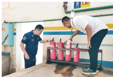
▲检查组抽查燃气公司灭火器情况。通讯员供图
