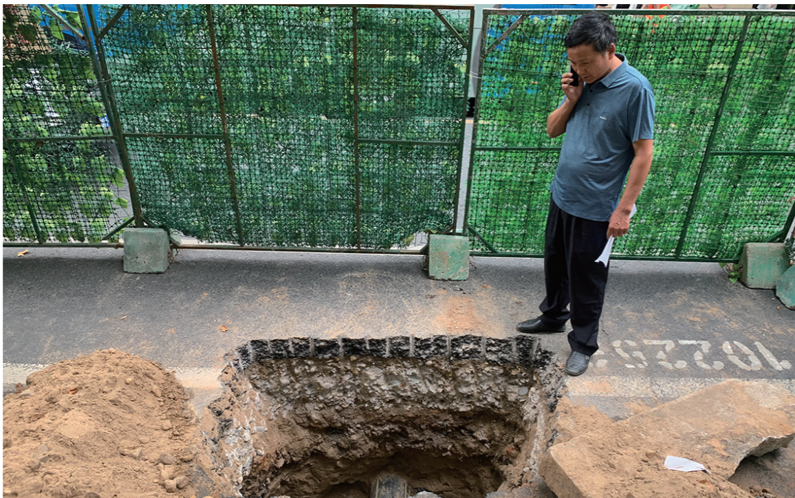
▲6月22日上午,人民路一处燃气管网改造开挖点黄土裸露,现场人士表示将于次日晚开始施工。记者 吴楚 摄
