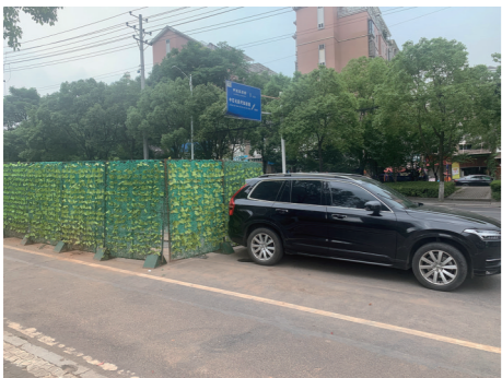
▲6月22日上午,枫溪大道污水管网项目施工现场,一台私家车停在围挡前。记者 吴楚 摄
