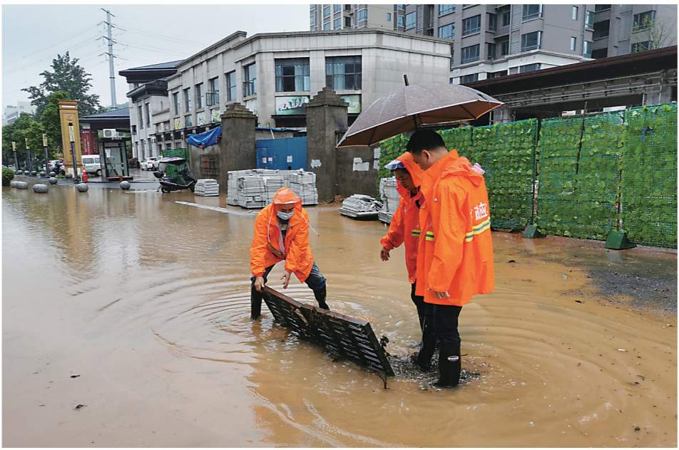
▲云龙示范区戴龙湾小区外,市政部门联合处置积水,保障市民出行安全。记者 伍靖雯 供图
