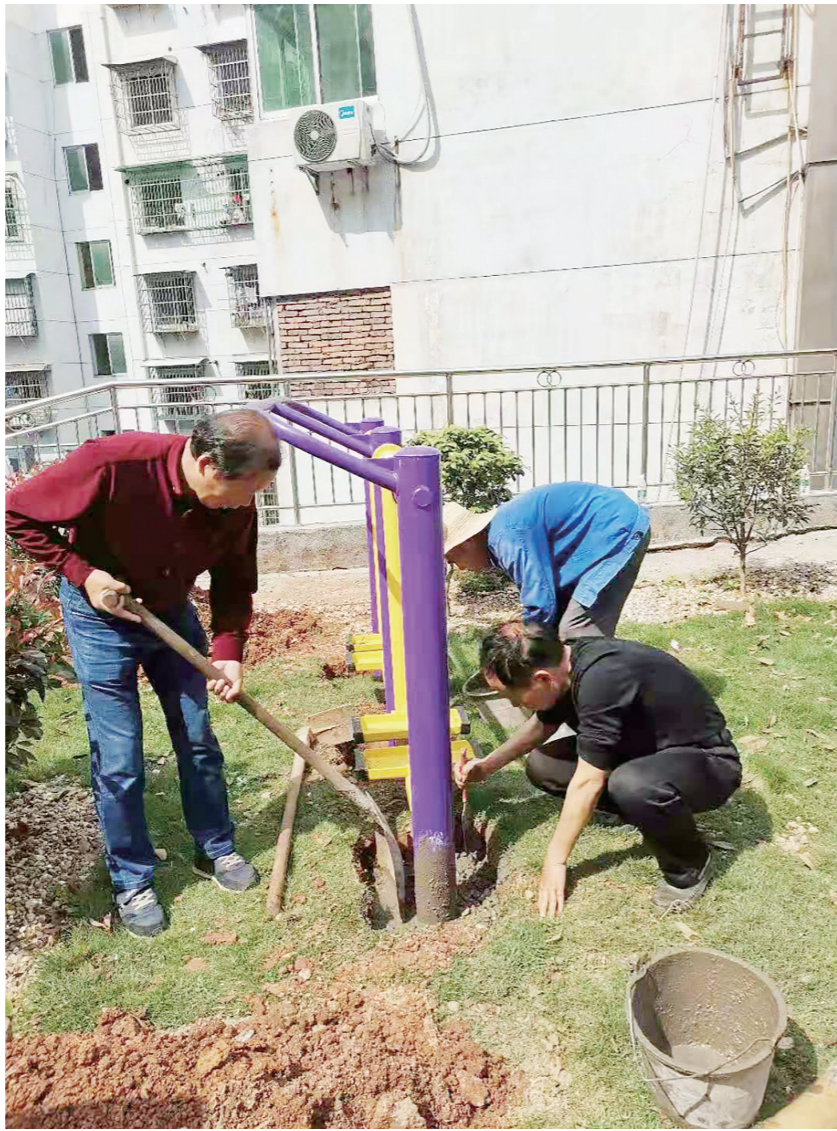
▲小区居民在安装健身器材。记者 杨凌凌 摄
