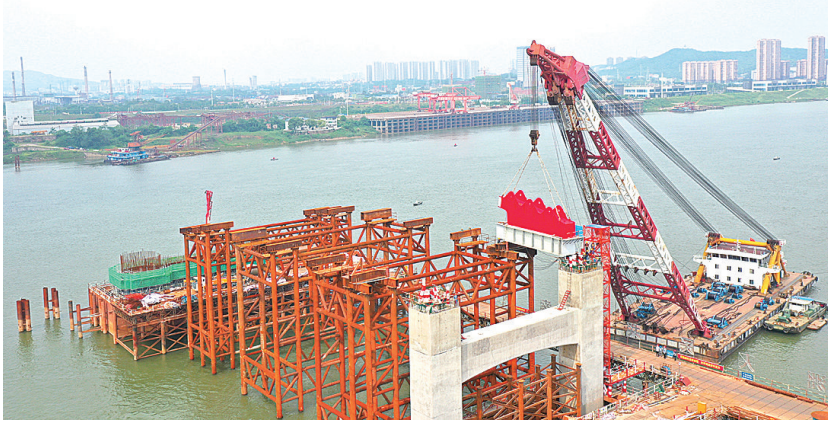
▲清水塘大桥西侧首节段钢结构吊装现场。 通讯员供图
