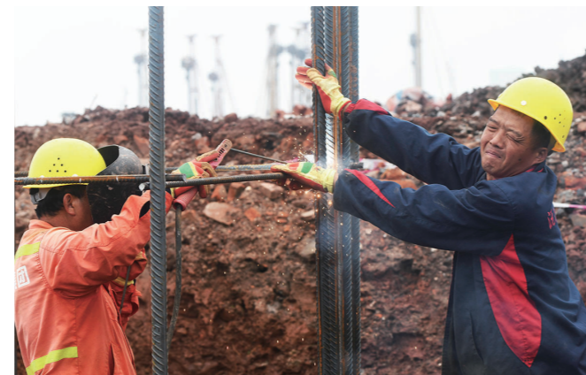
▲沈师傅(右一)闭着眼睛协助工友焊接钢筋。
