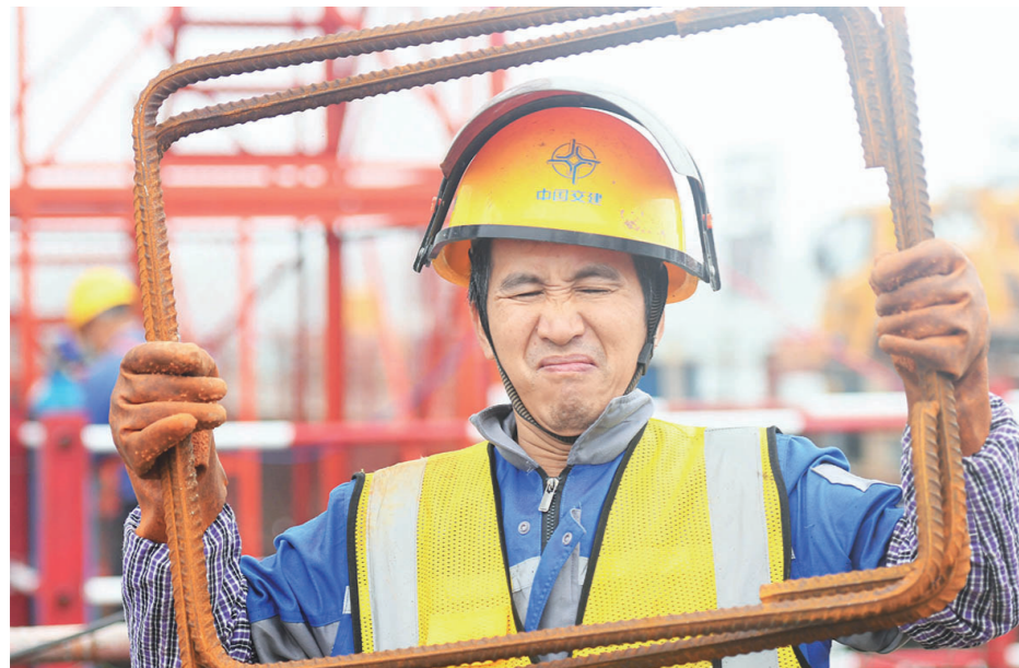
▲清水塘大桥施工现场,工人师傅在转运材料。
