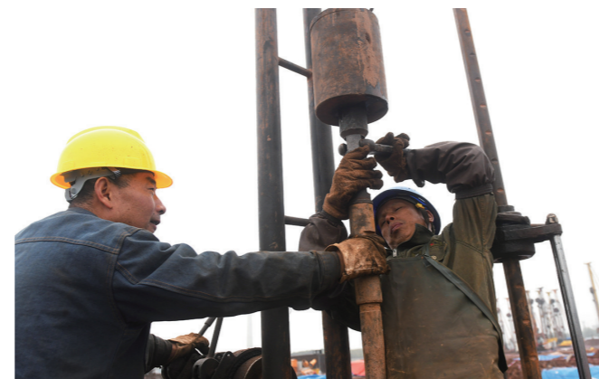
▲清水塘建设现场钻探工李立(左一)与工友合力给钻机加杆。
