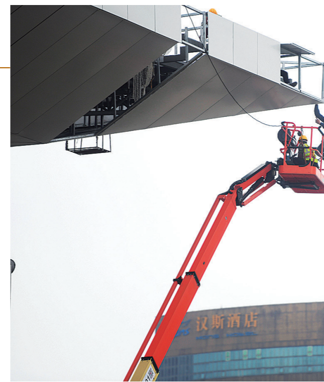
▲近日,株洲火车站改扩建工程建设现场,工人师傅在高空安装金属屋面檐口。记者 谢慧 摄
