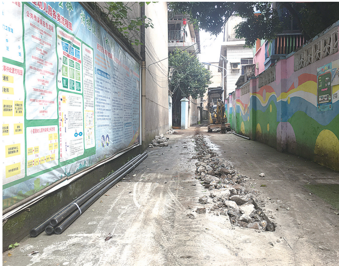
▲4月21日,水竹社区散户区,部分路段路面开挖,将埋设燃气管道。记者 刘平 摄
