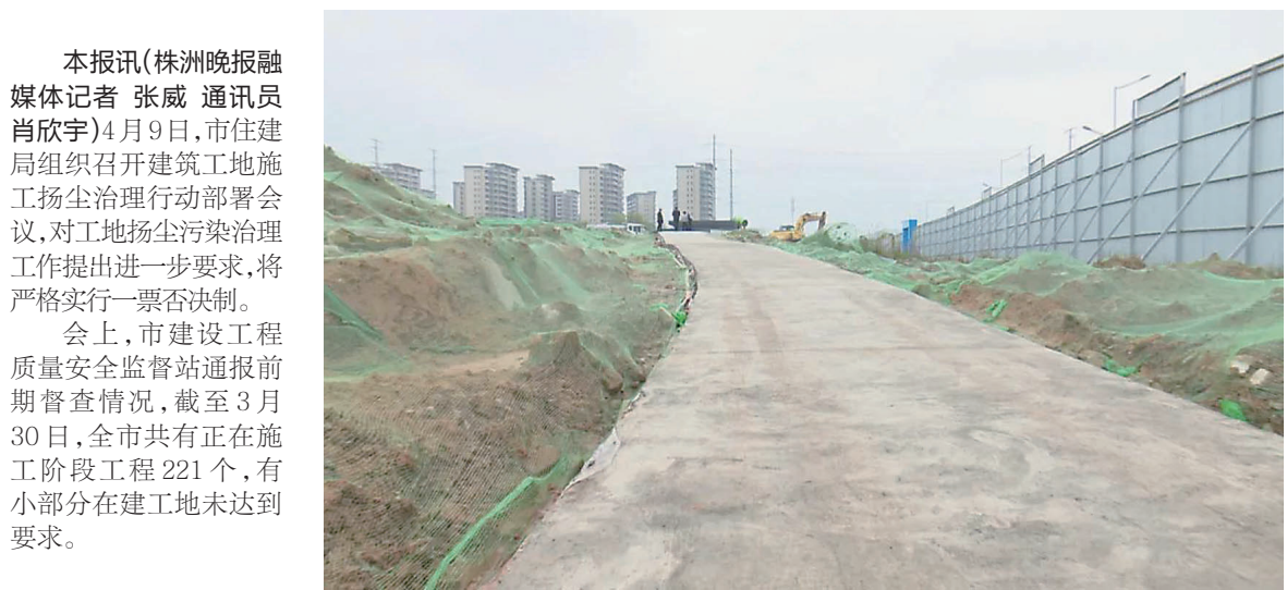
▲东投状元府工地整改后,施工道路已经水泥硬化,裸土覆盖防尘网。记者 张威 摄
