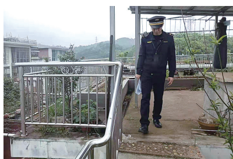
▲时代国际小区楼顶有“菜园”。 通讯员供图
